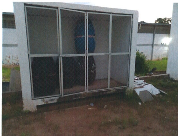
FOTO 26: Estrutura para armazenamento do lixo infectante
