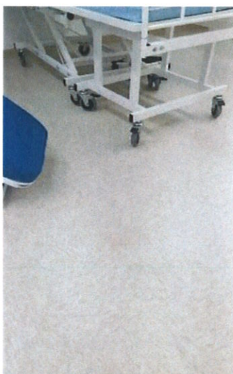
FOTO 16: Piso vinílico instalado no quartos PPP
