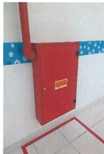
FOTO 12: Mangueira do hidrante sem fornecimento de água em tubulação, sem identificação
