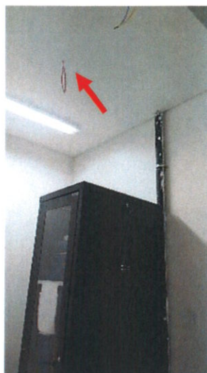
FOTO 10 e 11: Detectores de fumaça não instalados nos
